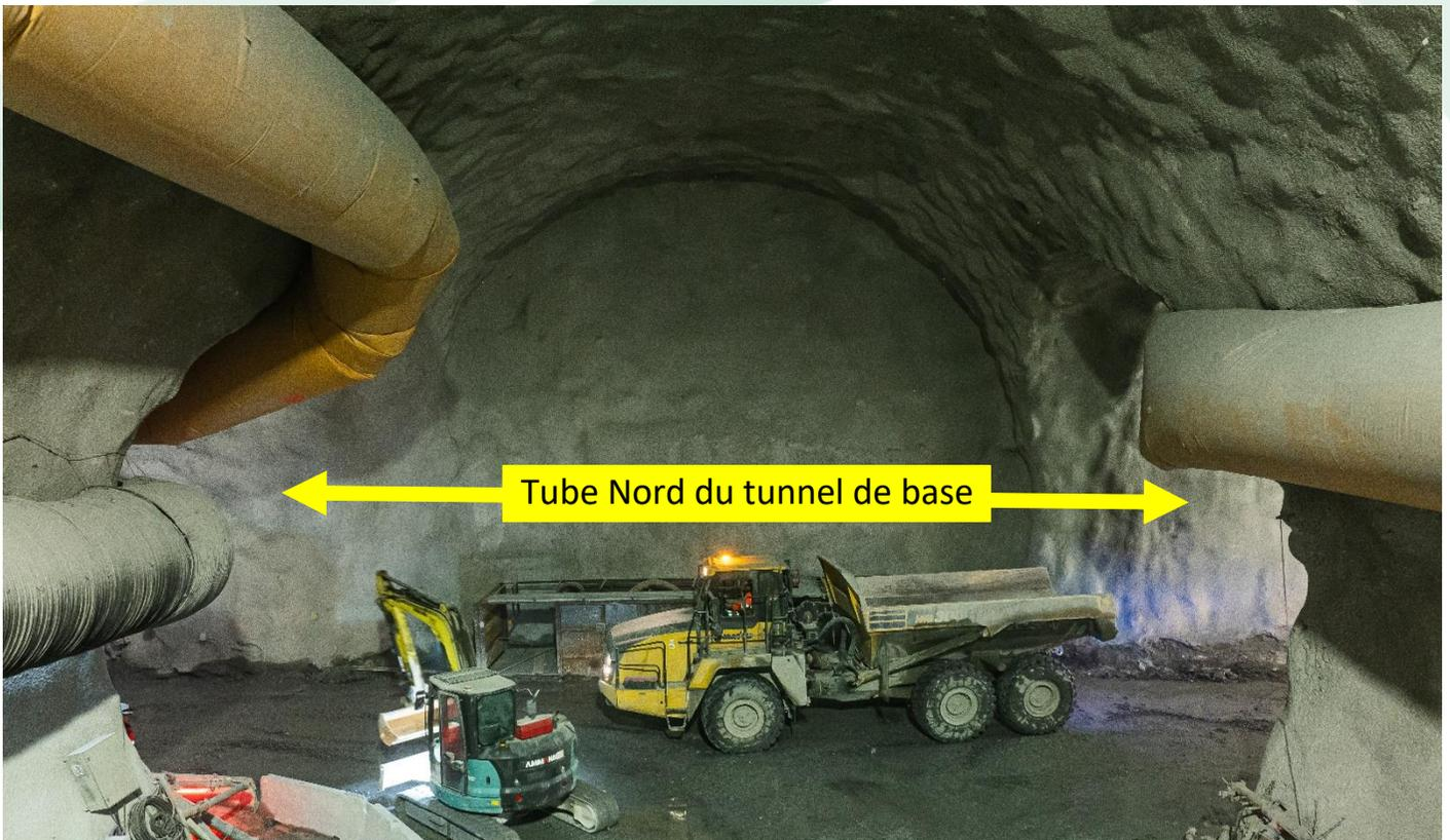
*Les engins se trouvent sur le tube nord du tunnel de base, le creusement se poursuit de chaque côté*
