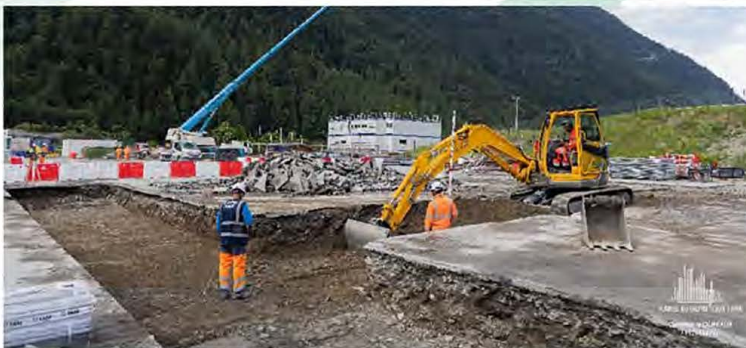
Terrassement pour les futurs casiers MATEX
