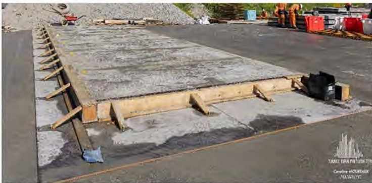
Éléments de l'écran acoustique en cours de fabrication – La Praz
