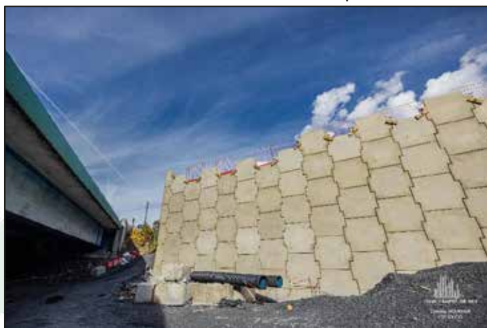
Montage du mur pour l'élargissement de la RD215
