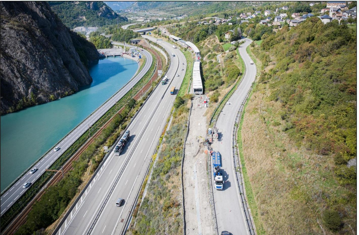
Sur la plateforme, les bureaux de la maîtrise d'œuvre sont terminés. Les modules constituant les futurs bureaux de la direction de projet du groupement s'assemblent. Parallèlement, l'installation de la centrale à béton se poursuit.
