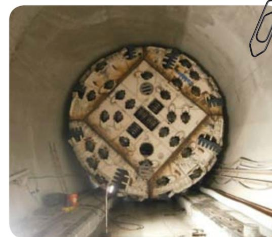
Il s'agit d'une machine de 6,30m de diamètres qui réalisera environ 7 km d'excavation pour les reconnaissances de la partie italienne du tunnel de base, au même titre que les 3 descentes réalisées en France.
