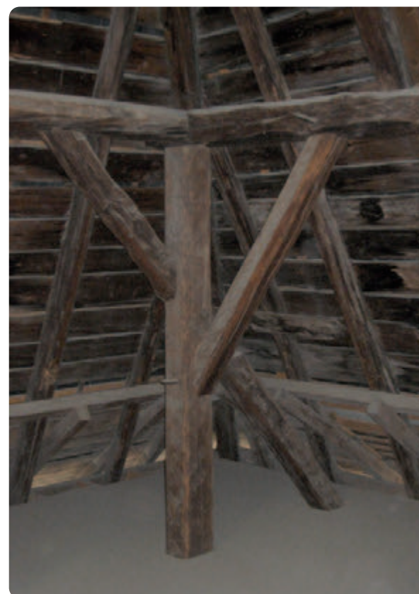
Pilier d'angle du toit de la Maison Blanche
