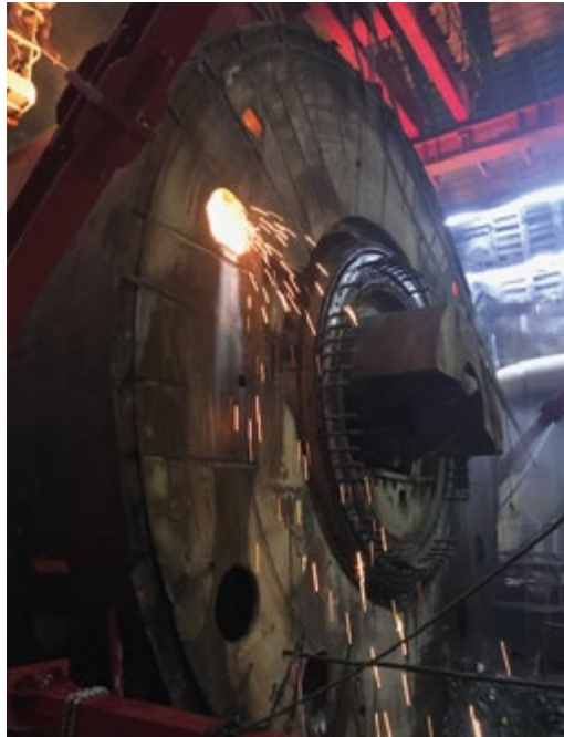
Démontage du tunnelier Federica
