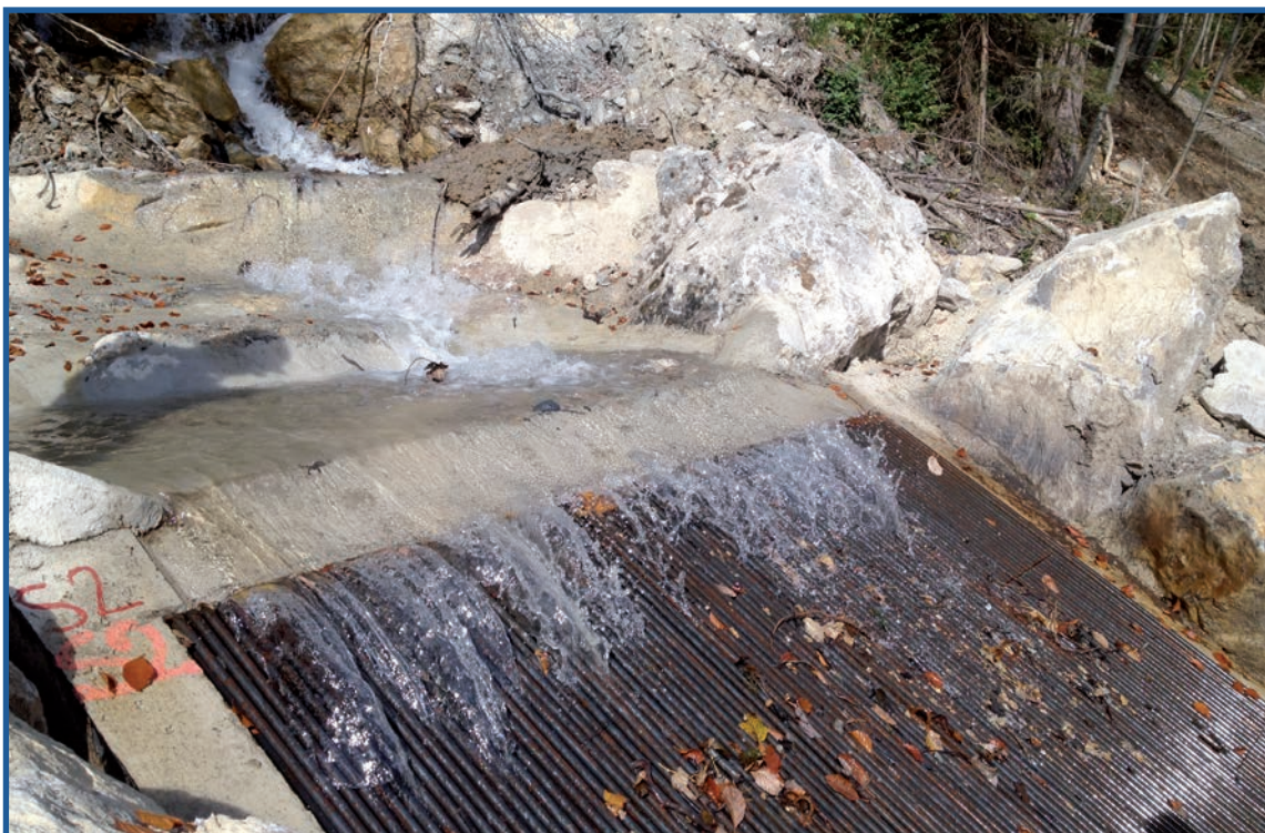
Une prise d'eau au niveau des sources
